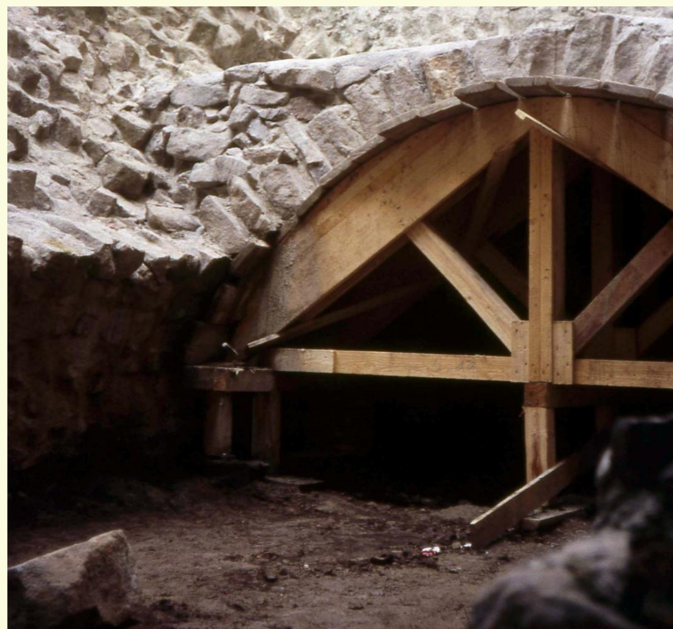
1982 konnte im Rahmen der Burgsanierung der hintere Gewölbeteil restauriert werden.
