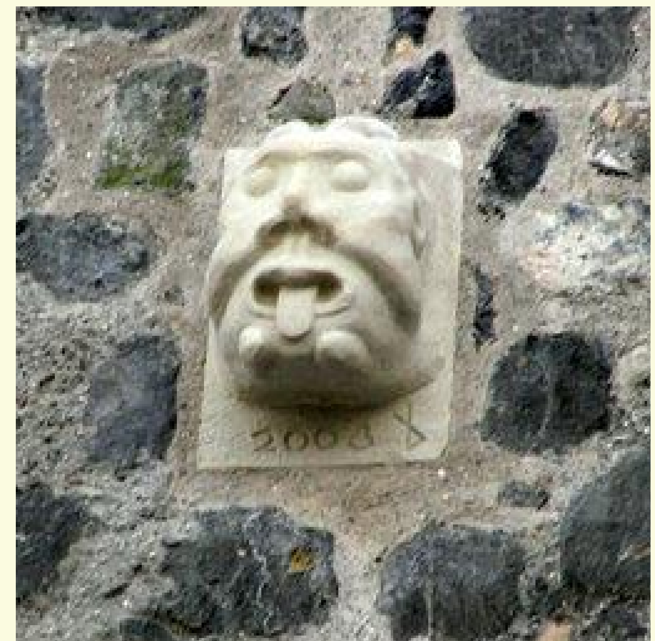
Ersetzung des total verwitterten Original-Neidkopfes durch eine Nachbildung (2008)
