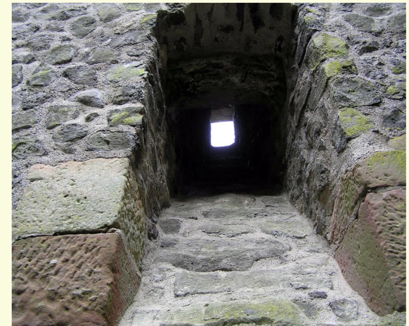
Küchenabzugs- oder Lüftungsschacht in der Ostwand
