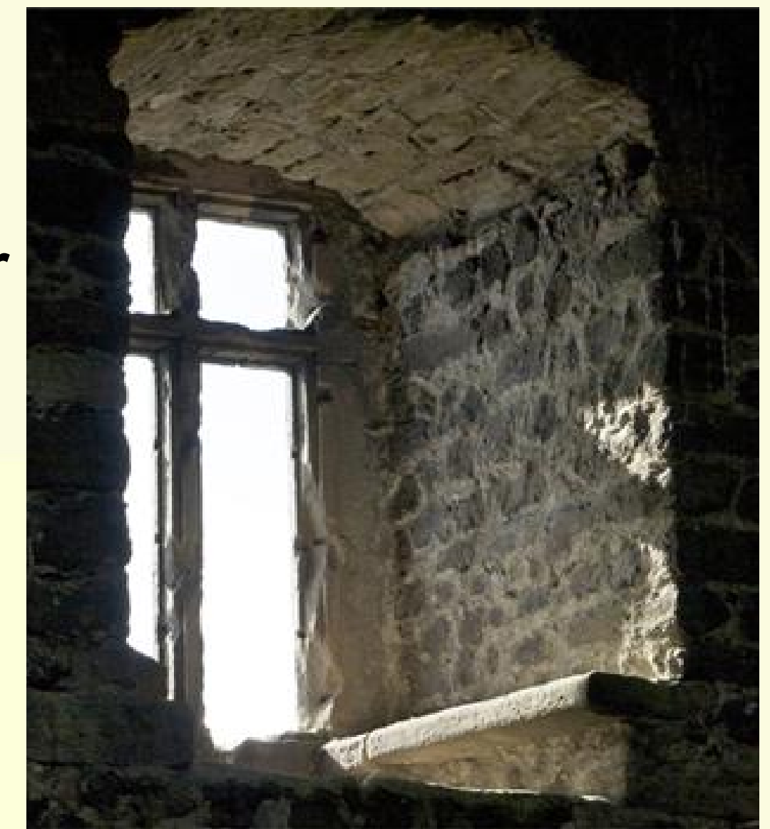
Sitznische im 2. OG an der Ostwand mit komplett erhaltenem Kreuzstockfenster
