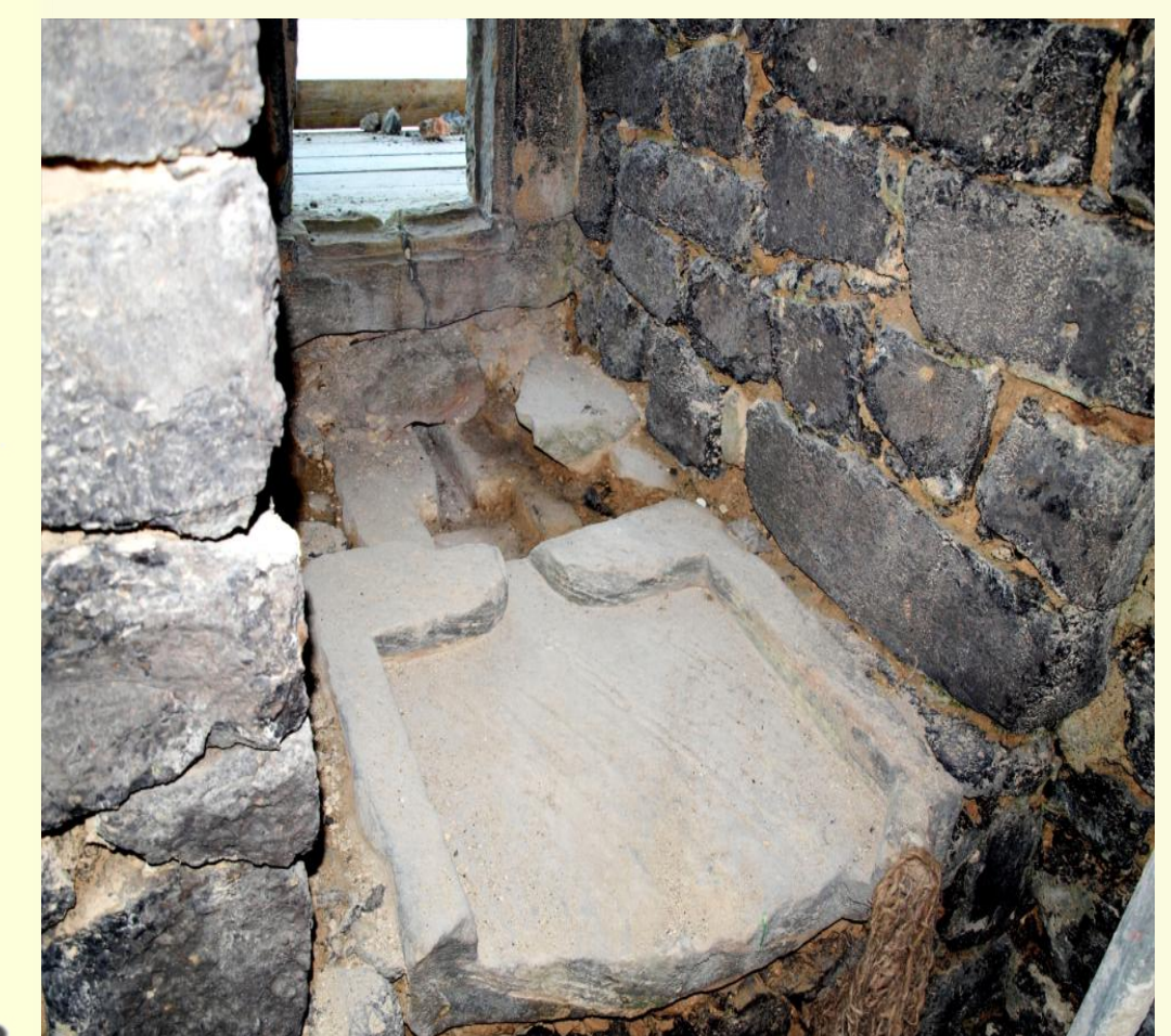
Zwei hintereinander liegende Ausgusssteine in der Fensternische der Westwand
